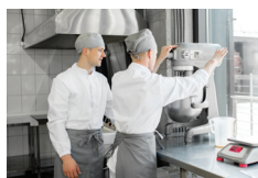
Ventilation i bageriproduktionen
